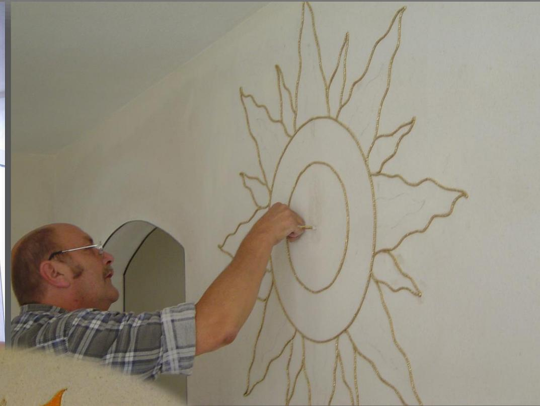
Die Konturen werden zuerst gezeichnet, ein Kleber aufgetragen und Kordel aufgeklebt. Erst dann wird mit Baumwollputz ausgefüllt.
